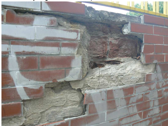
F75 Detailný pohľad na statickú poruchu horného okraja steny anglického dvorca pri severnom schodisku
