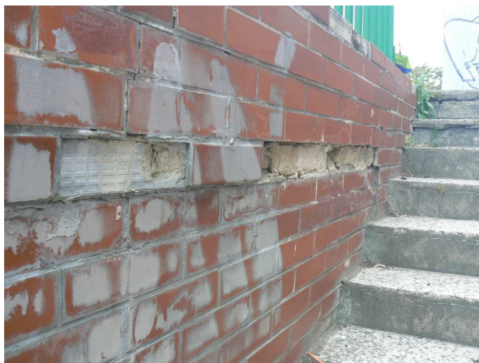
F74 Bočný pohľad na statickú poruchu horného okraja steny anglického dvorca pri severnom schodisku
