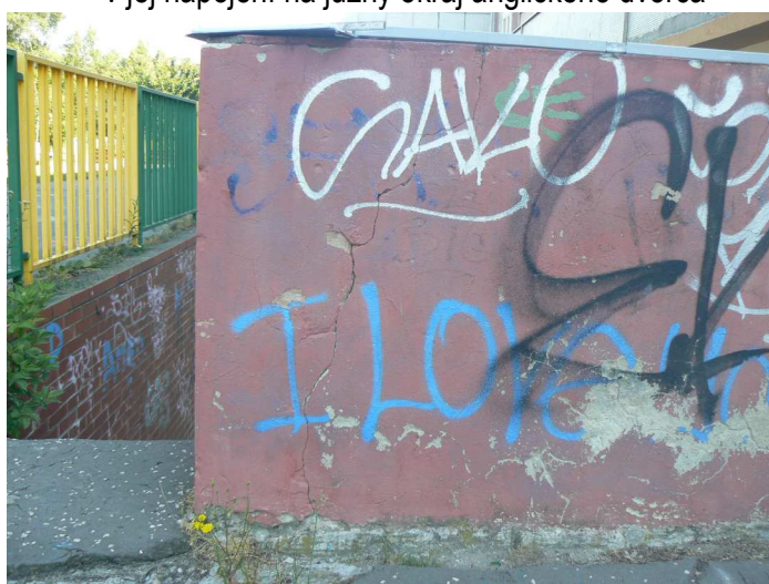
F72 Detailný pohľad na trhlinu v hornej časti južnej steny anglického dvorca
