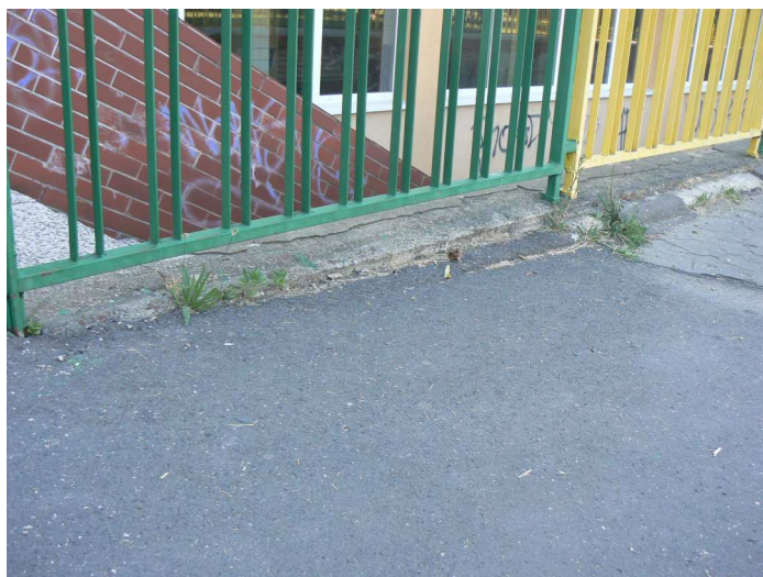
F68 Pohľad na presadnutie asfaltovej spevnenej plochy pri severnom schodisku do anglického dvorca
