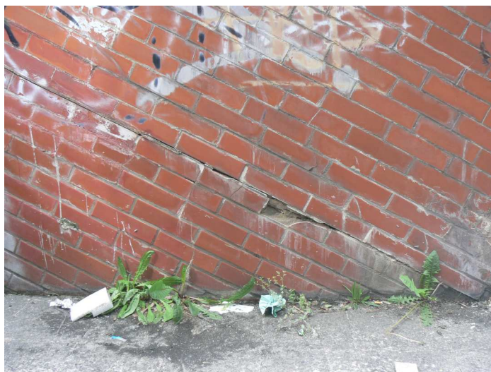
F80 Detailný pohľad na trhlinu v spodnej časti bočnej steny južného schodiska do anglického dvorca
