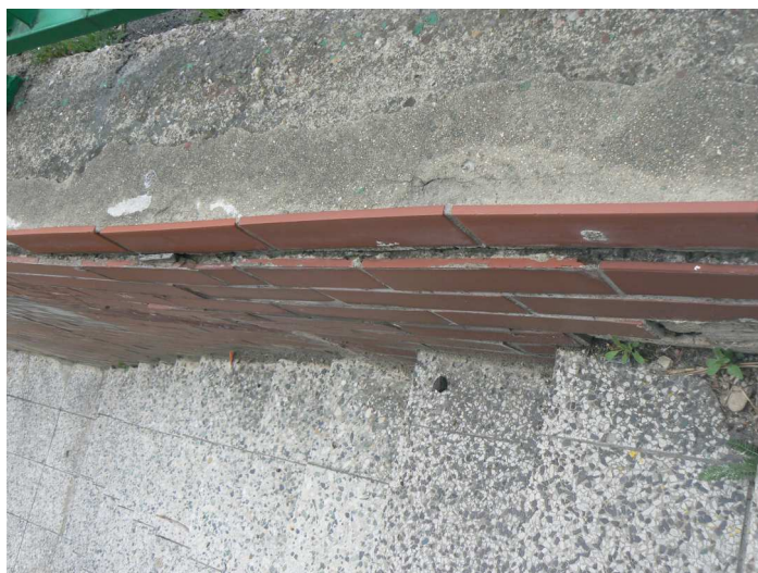
F73 Horný pohľad na statickú poruchu horného okraja steny anglického dvorca pri severnom schodisku
