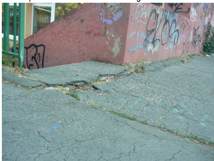
F70 Pohľad na presadnutie asfaltovej spevnenej plochy v jej napojení na južný okraj anglického dvorca
