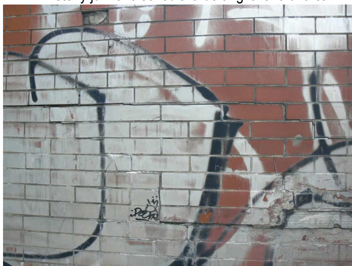
F83 Pohľad na horizontálnu trhlinu s vysunutím hornej časti južnej steny anglického dvorca
